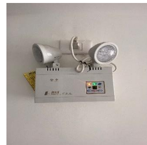
ภาพที่ 2.1-24 ระบบแสงสว่างสำรอง
