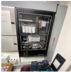
ภาพที่ 2.1-18 ระบบแจ้งเตือนเหตุเพลิงไหม้
